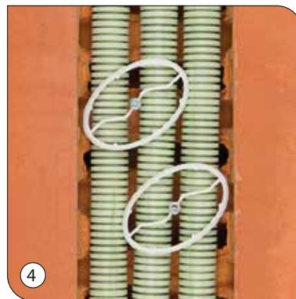
**DEU** Als Alternative kann der Clip gesichert werden mit einem 3 mm Stahlnagel. Wenn der Schlitz breiter als 60 mm ist, könnte der Clip eventuell als Nagelscheibe genutzt werden.
