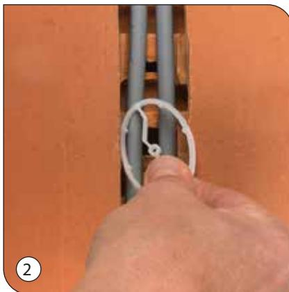
**DEU** Der Clip wird zur Hälfte in den Schlitz gelegt und im Uhrzeigersinn hinein gedreht.
